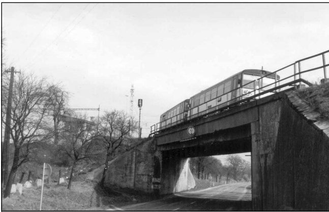
Výstavba nového železničního mostu přes silnici II/427 si vyžádá i opravu silnice v daném úseku. Na snímku motorový osobní vlak ze Starého Města do Kunovic, který dopravuje motorový vůz řady 810 mezi železničáři zvaný „orchestron“. Foto: Milan Kubiček
