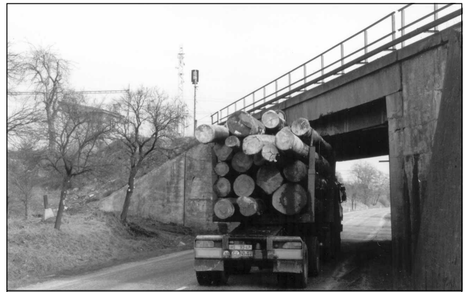
Železniční most byl v minulosti několikrát poškozen i nezodpovědnými řidiči, kteří převáželi nadrozměrný náklad a do průřezu mostu se prostě nevešli. Řidič na snímku s nákladem dubových kmenů našťastí projel, ale bylo to jen o fous. Foto: Milan Kubiček
