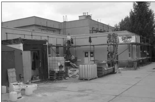
V říjnu a listopadu pokračovala za plného provozu rekonstrukce Křesťanské mateřské školy, Městské knihovny a Informačního centra v ulici Za Radnicí, kterou provedla stavební firma Kodrla Huštěnovice. Postupně byla vyměněna okna a dveře, zateplena fasáda, která dostala novou svěží barvu. V letošním roce výrazně změnilu svou podobu k lepšímu všechny mateřské školy na území Starého Města. Nejprve byla začátkem října dokončena oprava školky v Komenského ulici, krátce na to se vylepšila mateřská škola v Rastislavově ulici. Text + foto: Milan Kubiček
