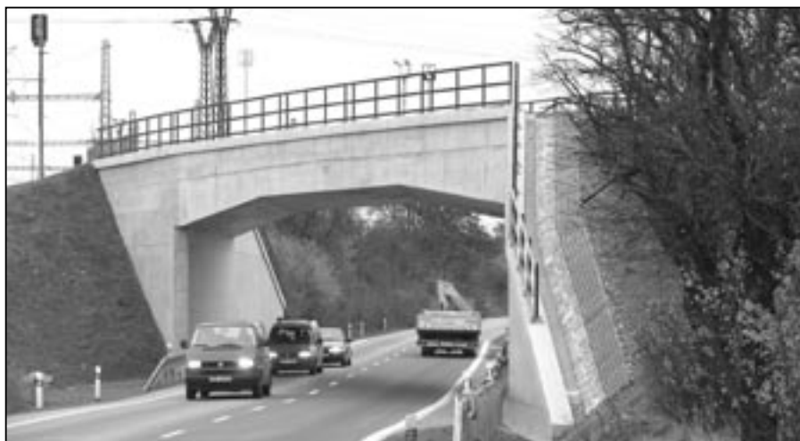
Železniční most v pátek 6. listopadu 2009.
