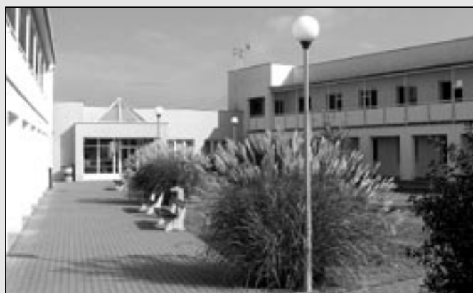
Domov pro osoby se zdravotním postižením tvoří komplex vzájemně propojených dvou ubytovacích budov a technické části. Veškeré prostory jsou bezbariérové, k dispozici jsou dva lůžkové výtahy.
