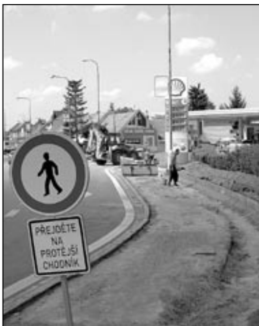
V srpnu bylo započato s výstavbou chodníku v Hradištské ulici. Snímek je z blízkosti čerpací stanice Shell.
