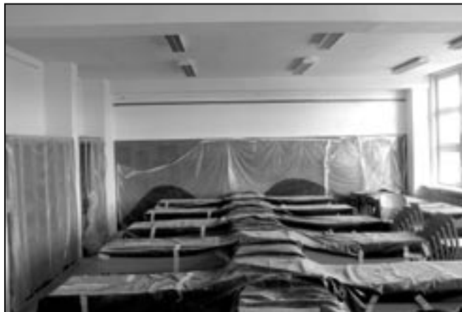
Po výměně velkého množství kabelů nastoupili do školních učeben malíři, natěrači a nakonec uklízečky.
