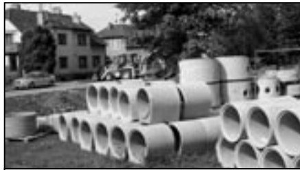
Stavební materiál pro revitalizaci sídliště na Kopánkách. Foto: MK
