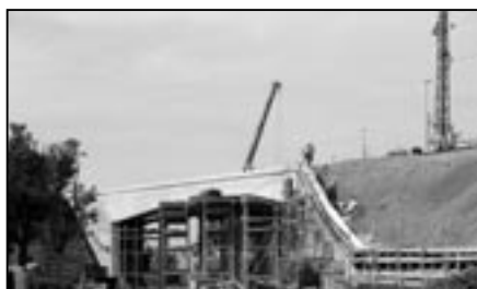
Železniční most na trati Staré Město – Kunovice dne 9. června 2009.
