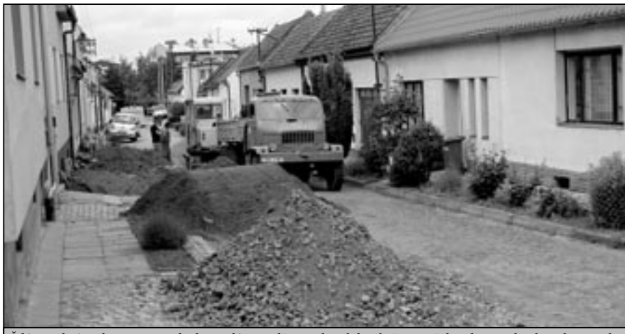
Čilý stavební ruch zaznamenali obyvatelé Metodějovy ulice, kde v květnu začala rekonstrukce kanalizace a bude se pokračovat opravou komunikace a chodníků. Foto: Milan Kubiček
