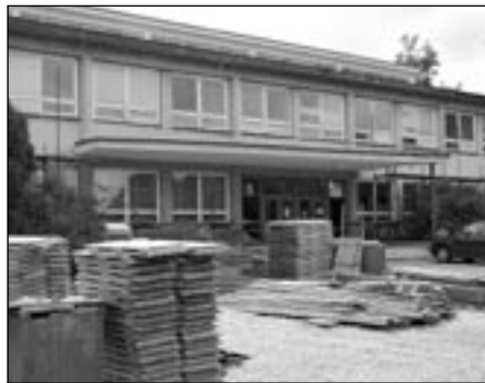
Budovu SOŠ a Gymnázia zahájilo lešení. Probíhá tolik očekávaná rekonstrukce budovy střední školy a domova mládeže. Foto: MK
