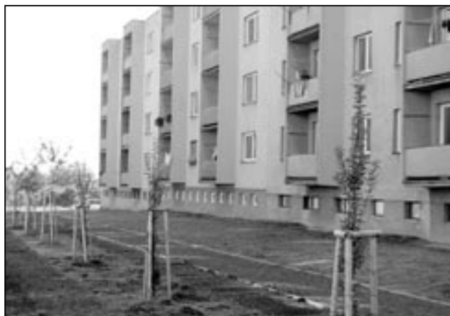
U bytových domů mezi ulicemi Alšova a Uprkova byly vysázeny stromky. Za poslední dva roky bylo ve Starém Městě vysázeno více než 3000 stromků a keřů. Tento počet mnohonásobně převyšuje počet vykácených, přestárých stromů.
