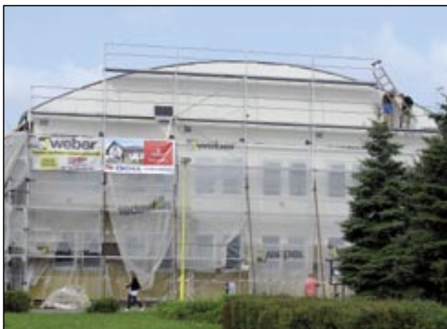
Budova zdravotního střediska počátkem srpna. V budově jsou vyměněna okna, původní rovná střecha se také výrazně změnila. Investiční akce bude dokončena do konce měsíce září.
