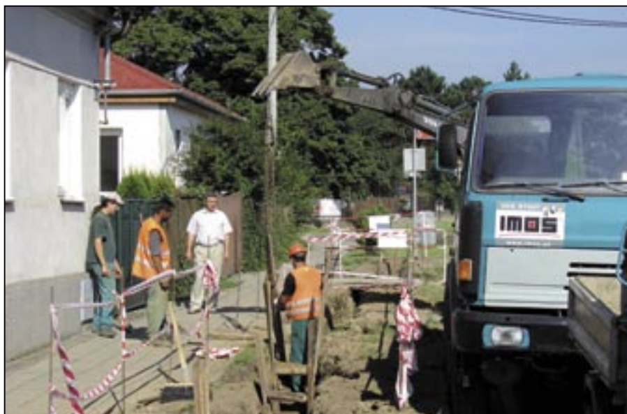
Začátkem srpna začaly stavební práce na rekonstrukci chodníku na Velehradské ulici. Starosta Josef Bazala přijel za dělníky na stavenišť ve čtvrtek 5. srpna 2010. Foto: Milan Kubíček
