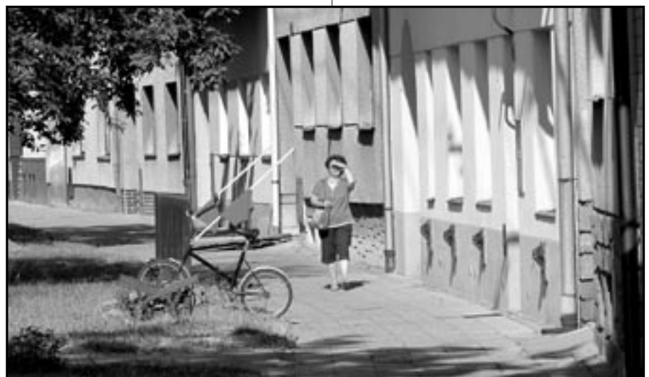
Severní strana náměstí Hrdinů je v současné době v rekonstrukci. Bude zde vybudován bezbariérový chodník, moderní osvětlení a městský mobiliář. Stavební práce budou mít hodnotu 12 milionů korun, radnici přispěje dotací 2,7 milionu korun Státní fond dopravní infrastruktury. Přibližně 320 metrů dlouhý chodník by měl být dokončen do konce roku 2010. Foto: Milan Kubíček
