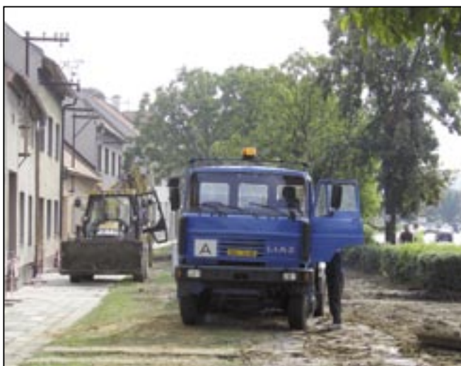
Severní stranu náměstí Hrdinů obsadila těžká stavební technika.
