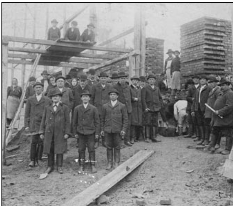
Stavba současné budovy radnice ve Starém Městě začala v listopadu 1907. Stavební, kamenické, štukatéřské práce byly zadány Antonínu Šupkovi, tesařské, pokryvačské, sklenářské a natěračské práce firmě Josefa Schaniaka a práce zámečnické Antonínu Miklíkovi. Na stavbu si obec půjčila u Zemědělské banky v Brně částku 170.000 Kč. Radnice byla postavena za velmi krátkou dobu a již v roce 1908 začala provizorně sloužit občanům. Počátkem roku 1909 byla radnice kompletně dokončena. Ilustrační foto: archiv
