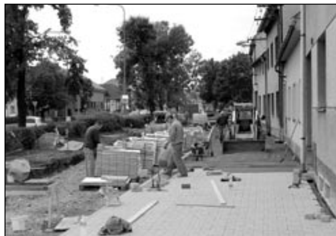
Na náměstí Hrdinů se pilně pracovalo při rekonstrukci severní strany náměstí. Hotovo bude do konce roku 2010. Foto: Milan Kubíček
