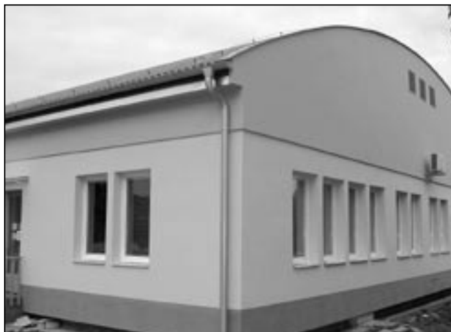
Budova zdravotního střediska, ve které jsou především ordinace dětských lékařů, se změnila k nepoznání. Pryč je tmavě modrý obvodový plášť z energeticky velmi neúspěšných tzv. „boletických panelů“.
