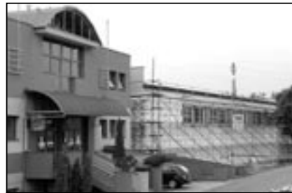
V pátek 1. října 2010 zaměstnanci firmy Kodrla pracovali na zateplení obvodového pláště budovy městské sportovní haly na Širůchu.
