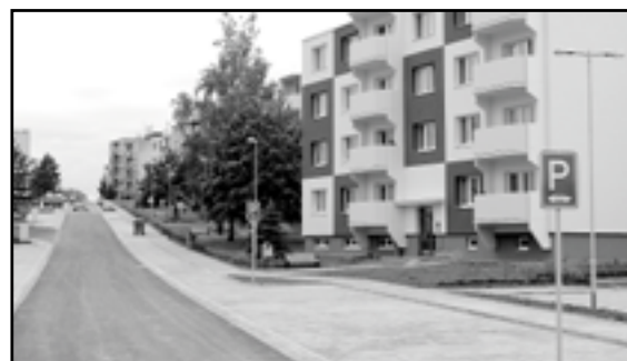
Komunikace a chodníky na sídlišti Kopánky v posledním den stavby 31. května 2010. Zhotovitelem revitalizace byla firma Outulný.
