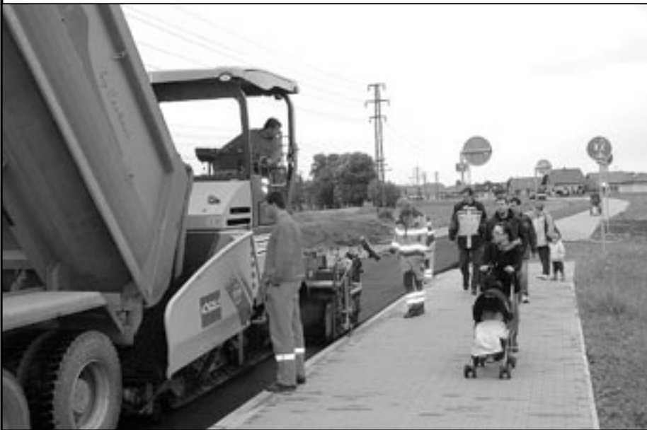
Dne 19. května 2010 byl položen živичný povrch na komunikaci spojující Zervavici s lokalitou Trávník.
