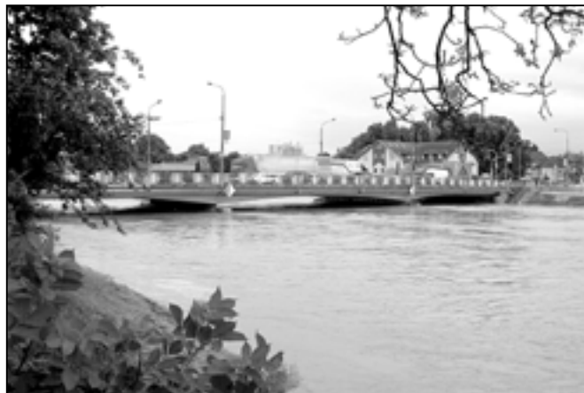
Zvednutá hladina Moravy pod silničním mostem. Foto: Vladimír Kučera
