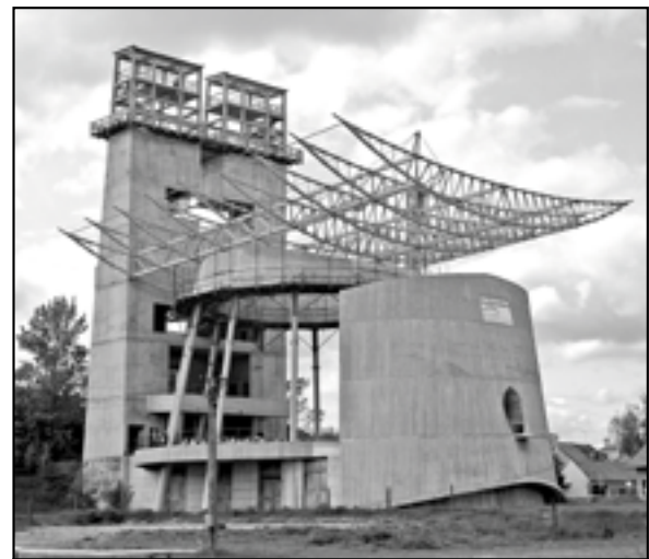
V sobotu 1. května 2010 se na staveništi kostela sv. Ducha uskutečnila bohoslužba, kterou celebroid duchovní otec staroměstské farnosti P. Miroslav Suchomel. Věřící zaplnili první podlaží budovaného svatostánku.
