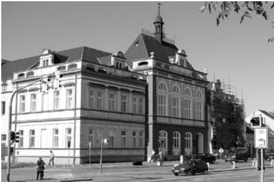
Pravá část budovy radnice je v současnosti pod lešením. Probíhá druhá etapa opravy vnějšího pláště budovy neboli fasády. Velmi dobré dílo odvádí pracovníci firmy STAVAKTIV, kteří pracují pod vedením Ing. Lubomíra Hučička. Foto: Milan Kubíček
