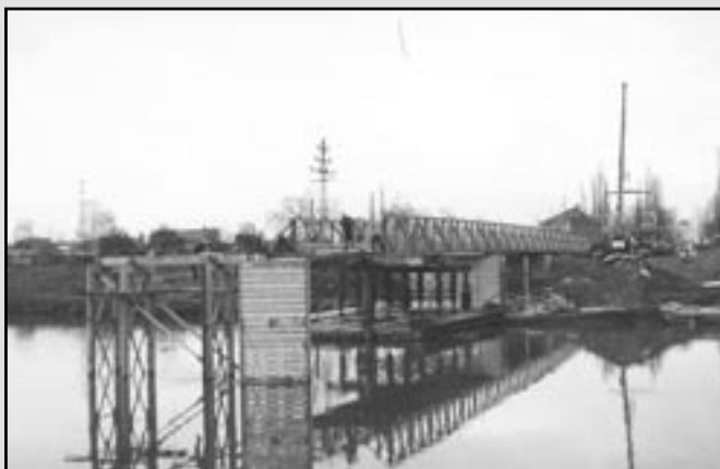
Dne 13. prosince 1994 došlo ke spojení břehů řeky Moravy ocelovou konstrukcí nové lávky. Vysouvání dlouhého tělesa trvalo několik hodin a jako jediní jsme tuto událost zdokumentovali. Foto: Milan Kubíček
