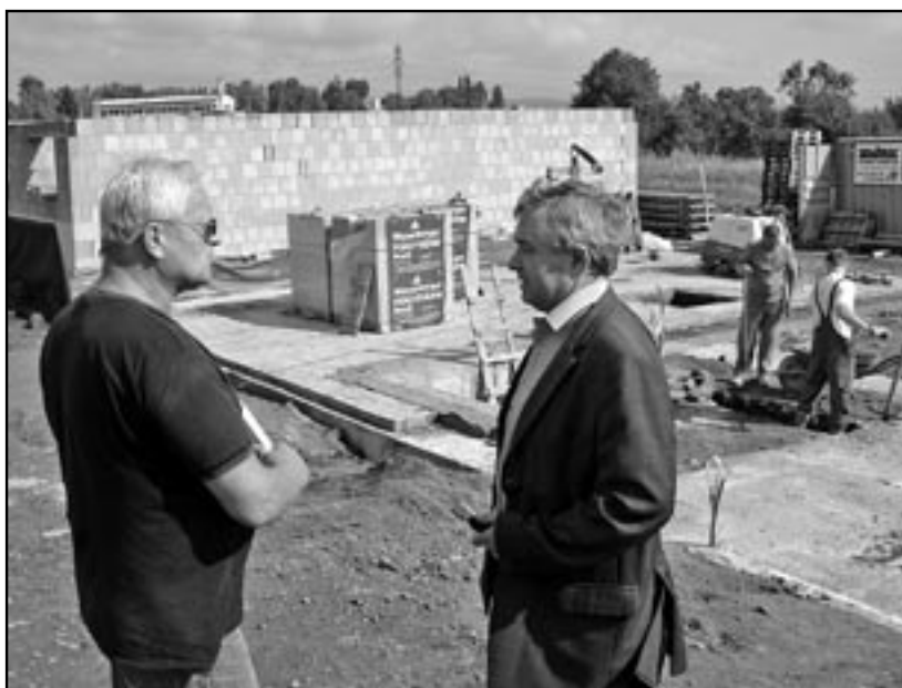
Starosta Josef Bazala při rozhovoru se stavbyvedoucím firmy Tradix panem Zdeňkem Ťokem. Na konci ulic Alšova, Úprkova vyrůstá bytový dům, kde bude po dokončení 66 bytových jednotek. Je předpoklad, že po jeho osídlení počet obyvatel Starého Města překročí sedmitisícovou hranici.
