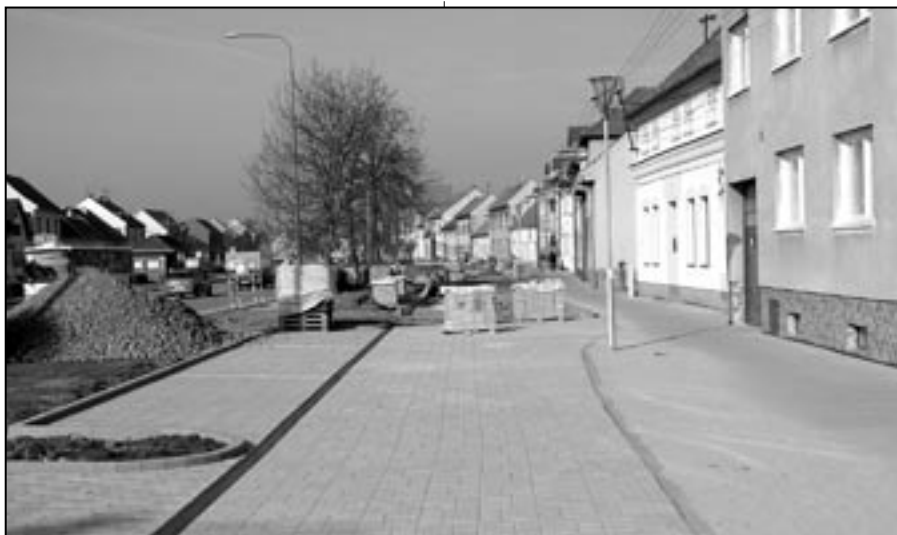
Koncem března bylo dokončeno vydláždění první části komunikace na severní straně náměstí Hrdinů ve směru od světelné křižovatky. Foto: Milan Kubíček
