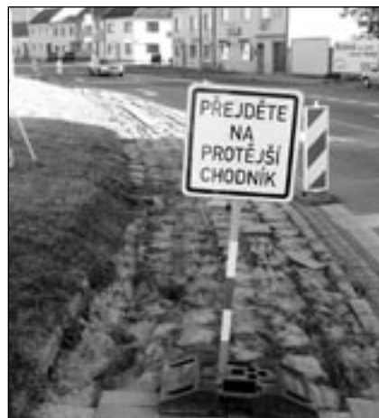
Během měsíce září pokračovala rekonstrukce chodníků na Velkomoravské ulici. Foto: MK
