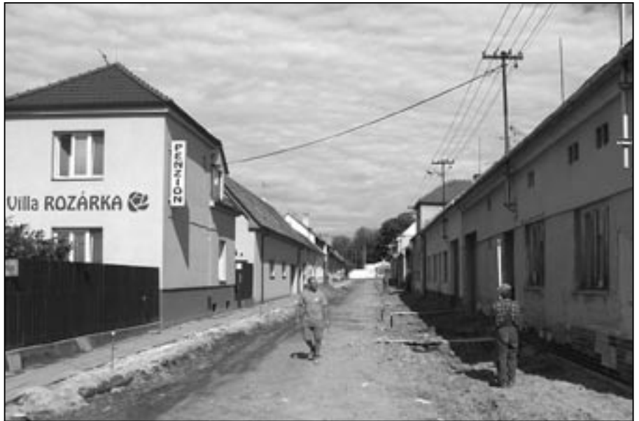
Ve Sportovní ulici pokračuje rekonstrukce komunikace a chodníků, kterou provádí uherskohradištská firma STAMOS. Stavební práce by měly být dokončeny do konce října 2011. Foto: Milan Kubíček
