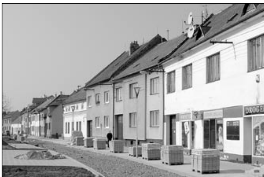
Ukončení stavby na náměstí Hrdinů by mělo být v termínu do 31. května 2011.
