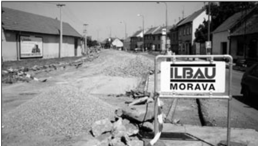
Vzpomínáte? Takto vypadala Velkomoravská ulice při rekonstrukci před třinácti lety.
