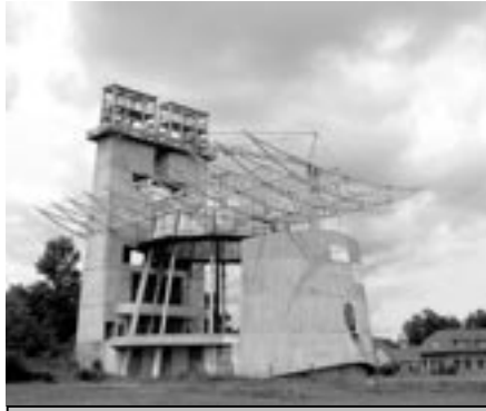
Kostel sv. Ducha dne 17. června 2011. V současnosti se pokračuje ve stavebních pracích na střeše kostela. Foto: Milan Kubíček
