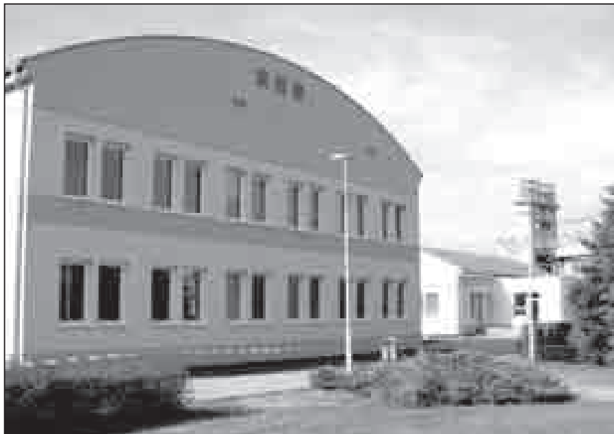
Stavební práce na budově zdravotního střediska probíhaly od června do října 2010.
