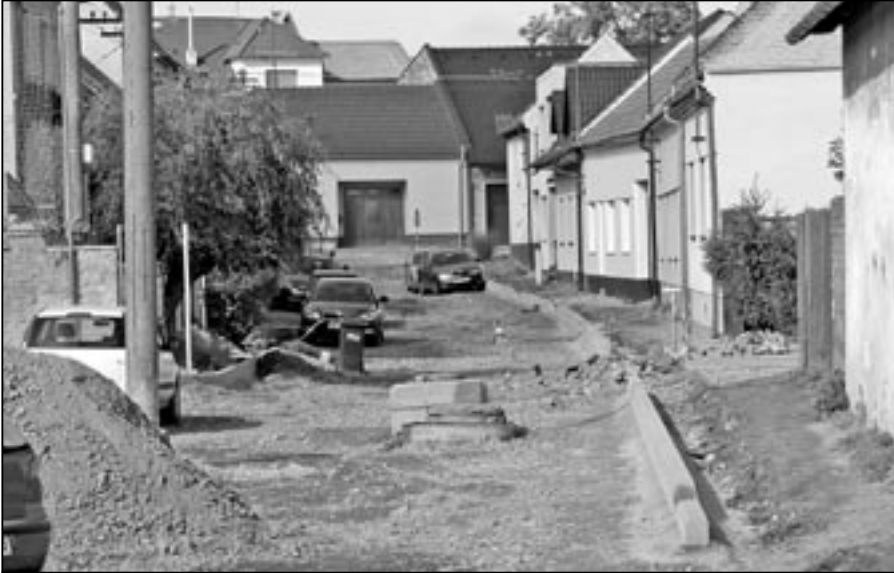
V průběhu měsíce října pokračovala rekonstrukce Rastislavovy ulice. Stavební práce budou dokončeny do konce listopadu. Snímek je z 30. září 2012. Foto: Milan Kubíček
