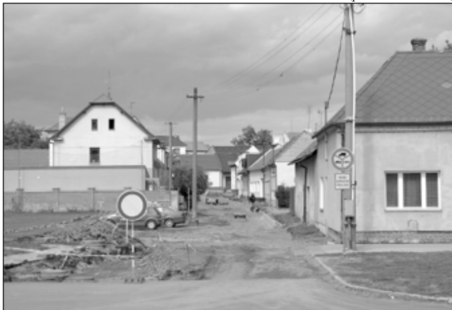
V průběhu měsíce října pokračovala rekonstrukce komunikace a chodníku v Rastislavově ulici.
