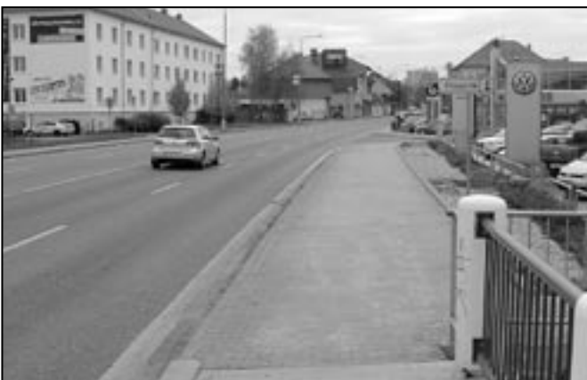
Bezbariérový chodník na Zervavici začíná od mostu přes Baťův kanál a vede až k mostu přes řeku Moravu. Foto: MK
