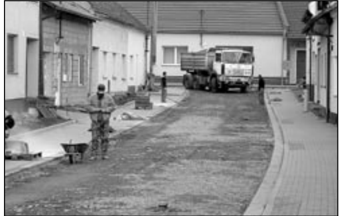
V horní části Rastislavovy ulice stavební dělníci dokončili pokládku chodníkové dlažby. Foto: MK
