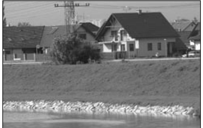
Během podzimu byla zpevněna část pravého břehu řeky Moravy v blízkosti lokality Trávník. Foto: Milan Kubíček
