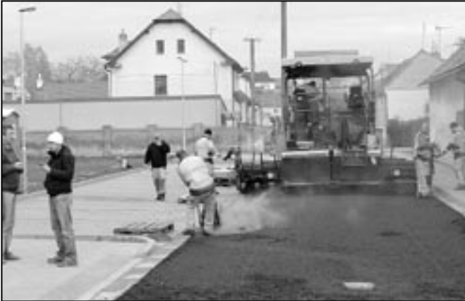
Ve čtvrtek 8. listopadu byla položena první vrstva živičného povrchu komunikace v Rastislavově ulici. Foto: Milan Kubíček
