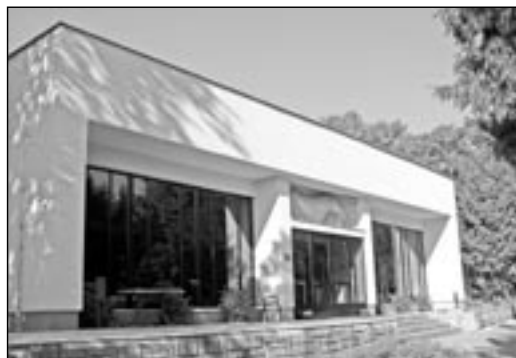
Přijďte do Památníku Velké Moravy. Jsou zde instalovány zajímavé výstavy. Foto: Milan Kubíček
