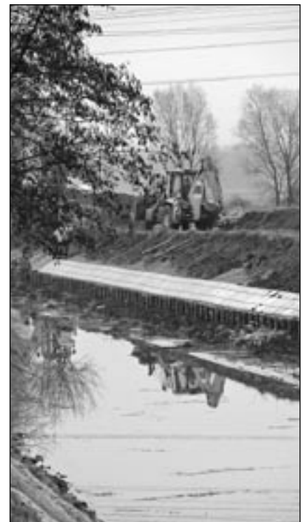
Stavební práce při zpevnění břehů Bařova kanálu. Foto: MK
