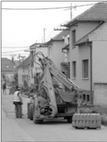
Do konce dubna 2012 bude ukončena rekonstrukce ulice V Zahradě. Foto: MK
