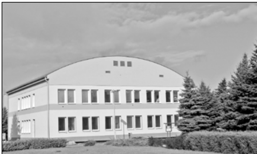
Budova zdravotního střediska krátce po rekonstrukci 28. srpna 2010.
