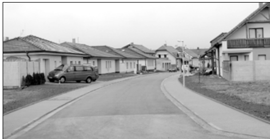
Nově vybudované komunikace slouží veřejnosti v lokalitě Trávník.
