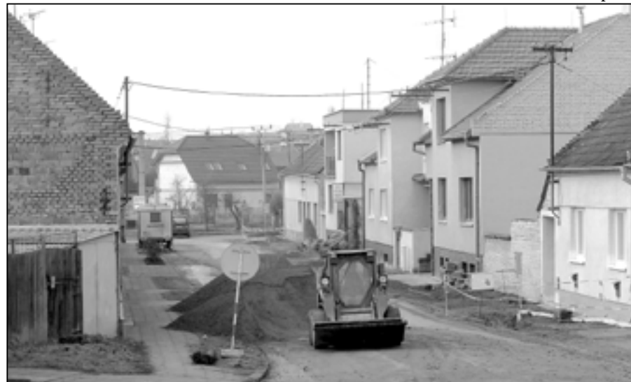
Od začátku listopadu 2011 se pracovalo na opravě vodovodu a kanalizace v ulici V Zahradě. V letošním roce se vylepší povrch místní komunikace.
