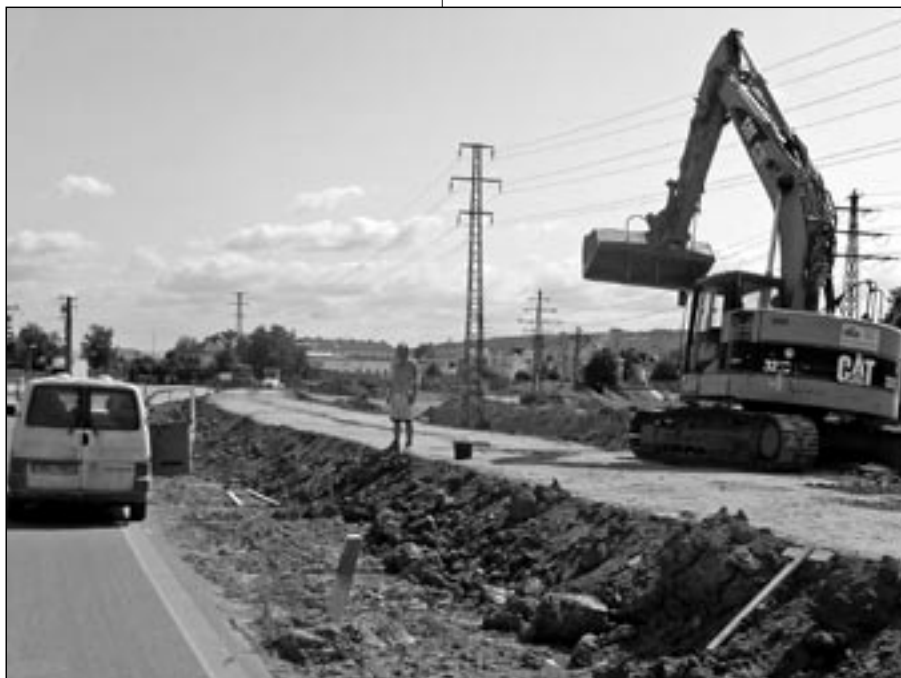
Protipovodňová hráz na Trávníku roste přímo před očima.
