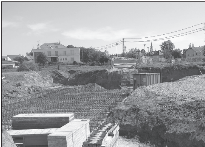
Stavební práce na výstavbě nové lávky přes suchý poldr dne 8. září. Foto: Milan Kubíček
