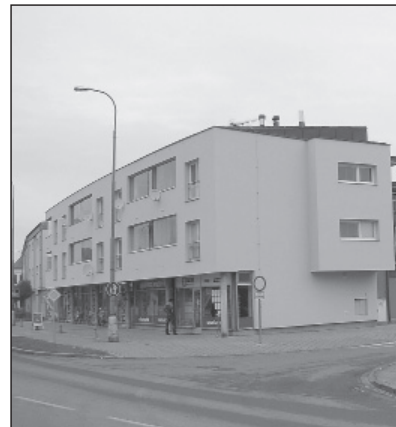
Bytové domy č. p. 2049 a 2050 na Velkomoravské ulici mají novou fasádu a zateplený plášť budovy.
