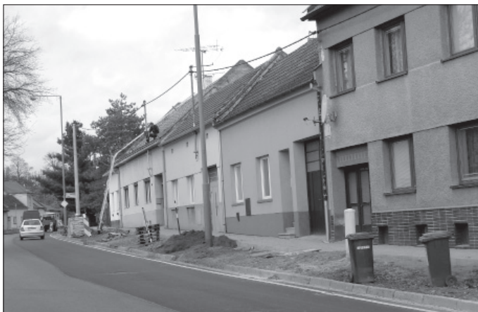
V říjnu pokračovaly stavební práce na akci Bezbariérový chodník na ulici Velehradská a U Sklépka. Foto: Milan Kubíček
