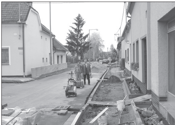
Starosta Josef Bazala navštívil Michalskou ulici, kde pracovníci firmy STA-VAKTIV pana Ing. Lubomíra Hučika provádí rekonstrukci chodníku.
