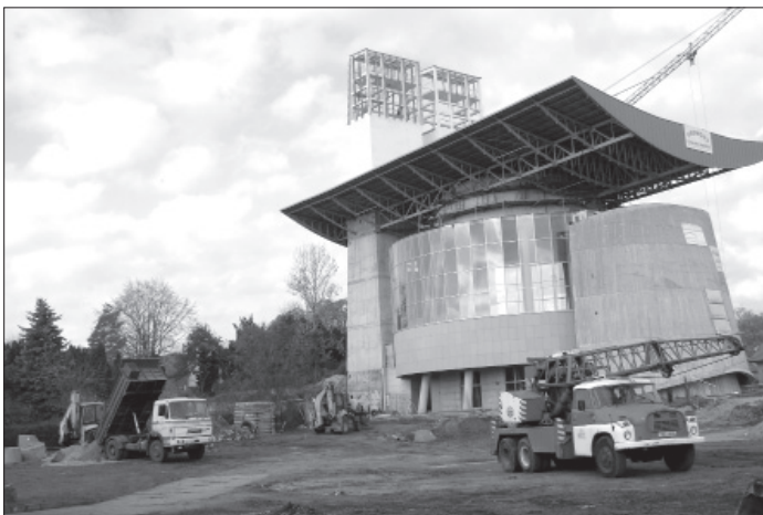
Dne 18. října byla slavnostně zahájena stavba Event centra u Památníku Velké Moravy. V následujícím týdnu začaly stavební práce na prostranství mezi Jezuitskou ulicí a kostelem sv. Ducha.
