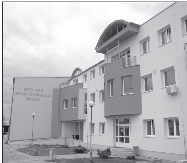
Na snímku zrekonstruovaná budova městské sportovní haly ve směru od hřiště. Stavební práce provedla firma Stavebniny Kodrila s. r. o. Huštěnovice. Foto: MK
