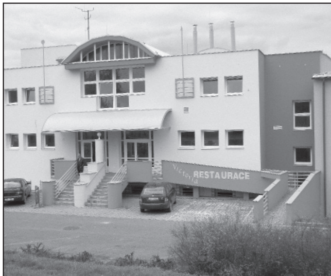
V průběhu letošního léta bylo provedeno zateplení přístavby víceúčelové sportovní haly na Širůchu. Objekt, ve kterém sídlí také restaurace Victoria, se může pochlubit novou fasádou. Foto: Milan Kubiček
