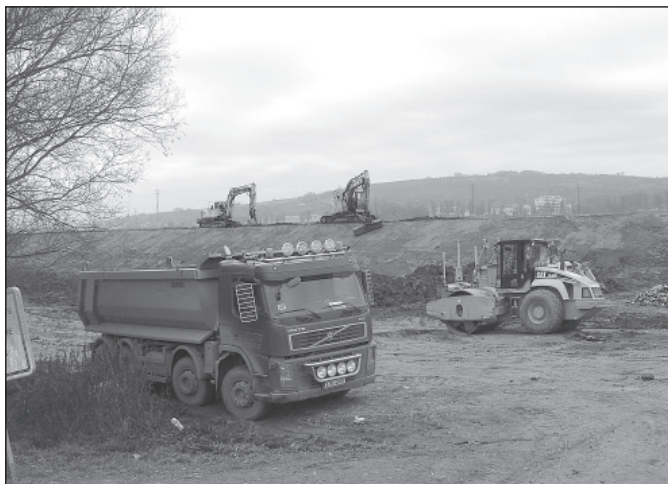
Za Baťovým kanálem ve směru k Rybárnám vyrostla mohutná protipovodňová hráz.
