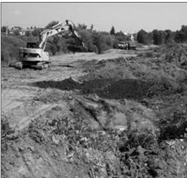
Úprava koryta a břehu Salašky.
