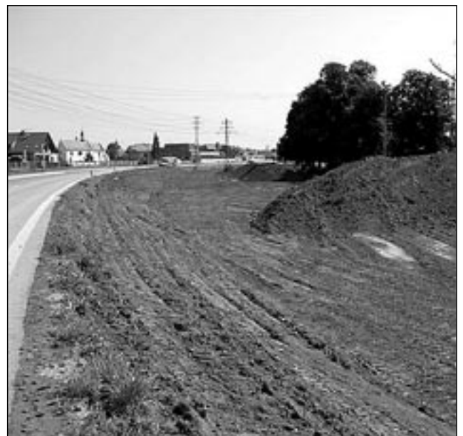
Příprava hráze na Trávníku.
