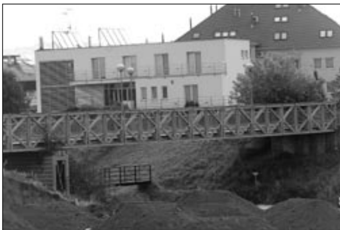
Lávka přes Bařův kanál se nyní opravuje. Foto: Milan Kubiček
