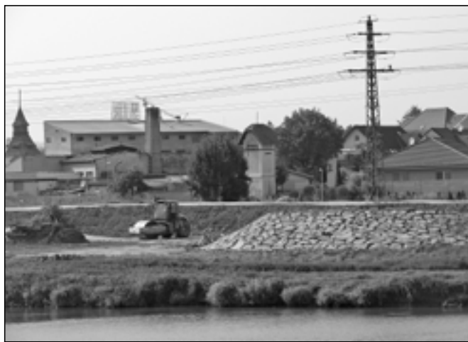
Stavební práce na pravém břehu Moravy v blízkosti lávky Baťova kanálu.
