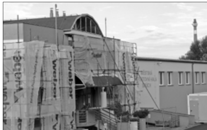
V červenci byla zahájena stavba Zateplení přístavby víceúčelové sportovní haly na Šírůchu. Na snímku vchod do haly a restaurace Victoria.
