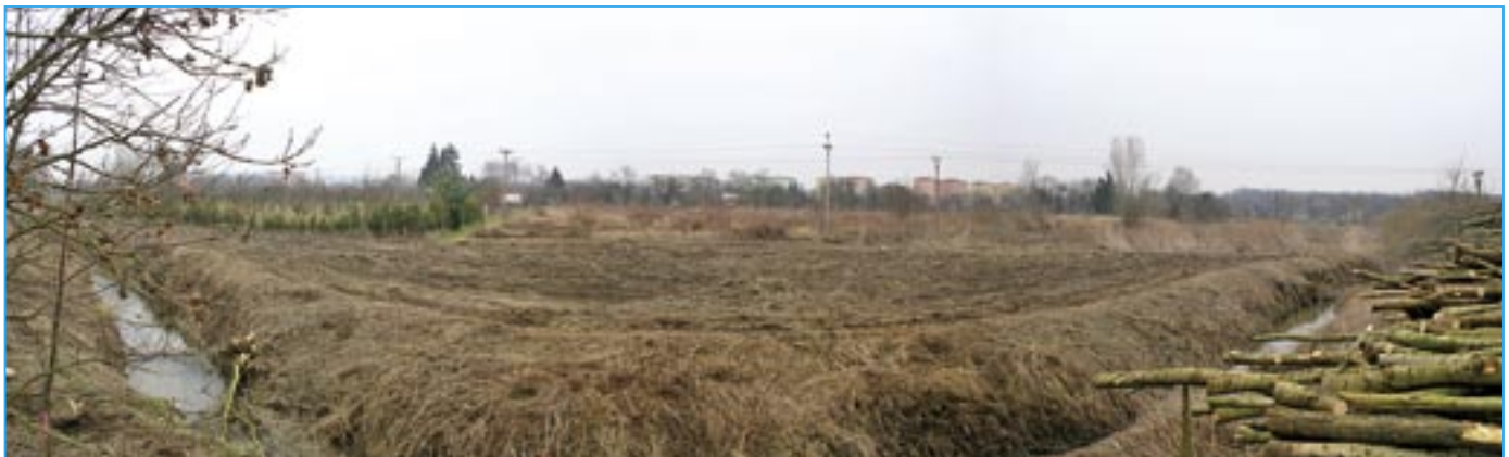
V březnu se uskutečnilo potřebné dokácení stromů a náhradní výsadba. Stavba je rozdělena do 24 stavebních objektů, na kterých budou práce běžet současně. Foto: Bc. Robert Januška
