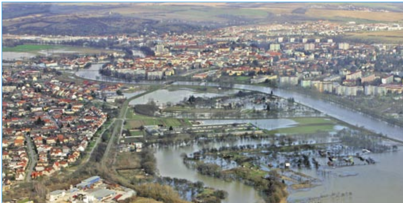
Dne 21. března byla zahájena stavba protipovodňové ochrany Starého Města a Uherského Hradiště před vysokými průtoky na řece Moravě. Jedná se o kombinaci zemních valů, zdí či obtoku, které postupně vyrostou na obou březích řeky a potoka Salaška. Na ilustračním snímku velká voda v řece Moravě dne 3. dubna 2006.
