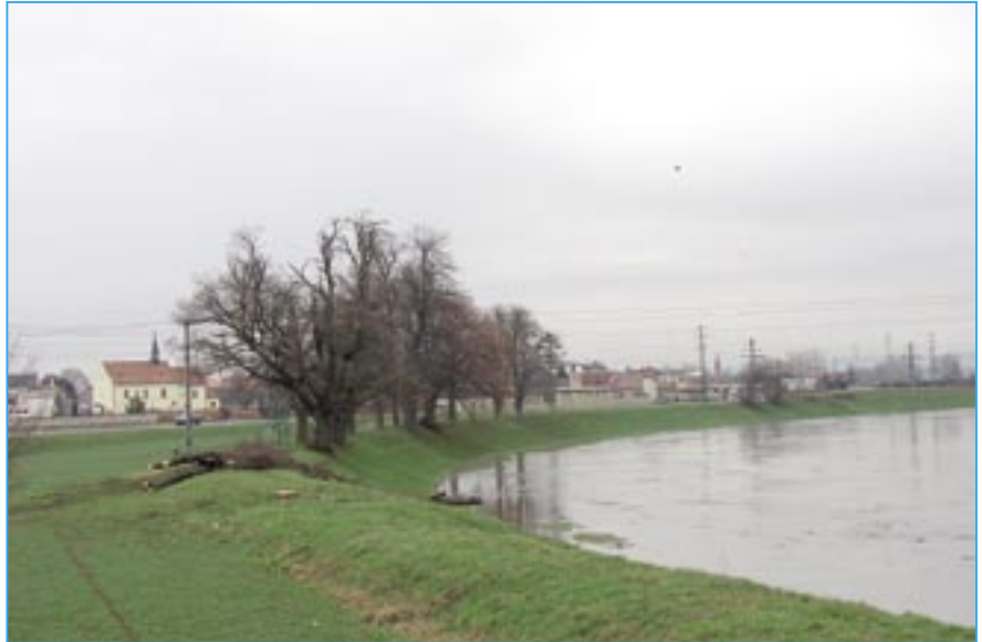
Stavební úpravy se budou týkat obou břehů řeky Moravy.
