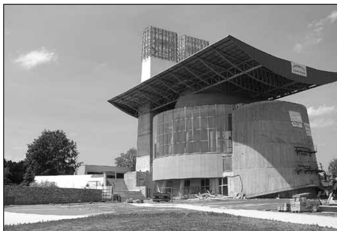
Pokračuje výstavba Event - centra a náměstí Velké Moravy. Před dokončením je také stavba kostela Svatého Ducha, který bude dominantou nového náměstí. Foto: Milan Kubíček
