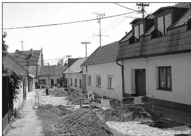
V ulici Zelnitiusova byla provedena rekonstrukce vodovodu. V červenci bude pokračovat rekonstrukce komunikace, chodníků a veřejného osvětlení. Foto: MK
