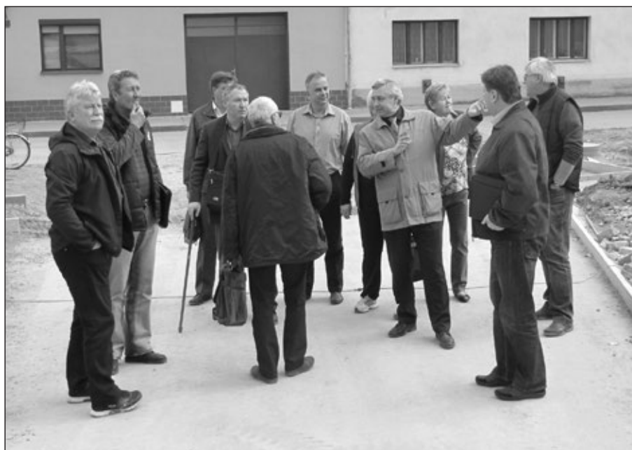
Starosta Josef Bazala (na snímku uprostřed) seznámil členy zastupitelstva města s dosavadním průběhem stavebních prací.
