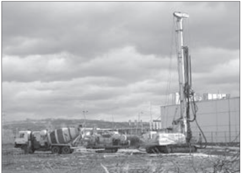
Již krátce po slavnostním zahájení stavby marketu UNI HOBBY začaly stavební práce. Snímek je z pátku 6. prosince.
