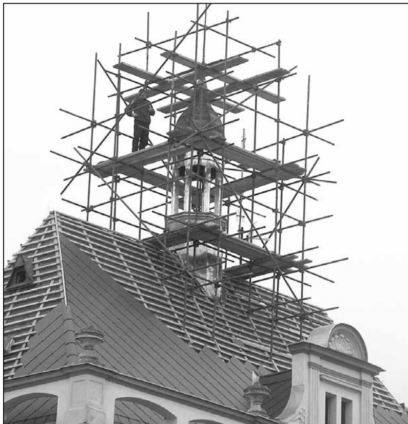
Zároveň s opravou věžičky dostala radnice na sklonku roku 2004 novou střechu.
