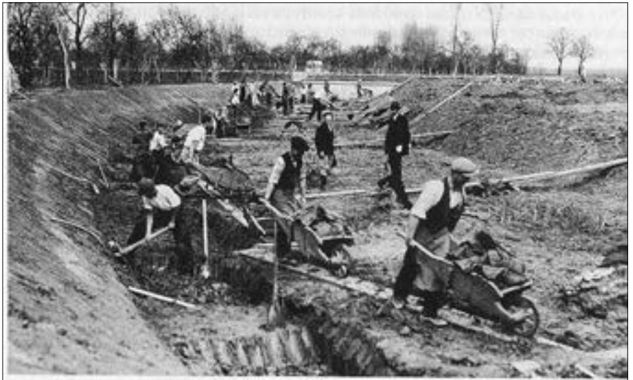
Práce na korytě kanálu mezi Spytihněví a Uh. Hradištěm v dubnu r. 1935, snímek J. Vanhara
