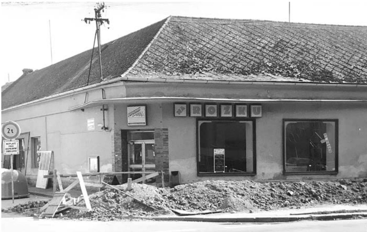
Potravin Na Rožku těsně před demolicí
