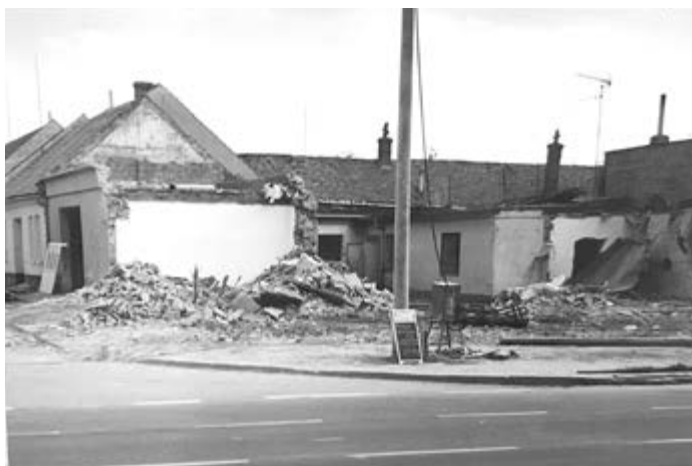
Původní budova po demolicí
