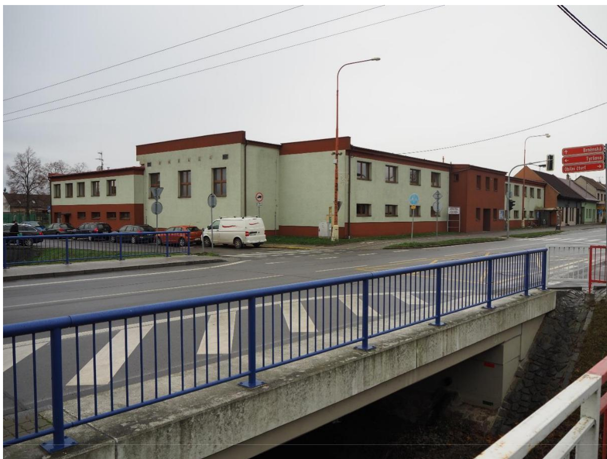
Budova Společensko-kulturního centra
