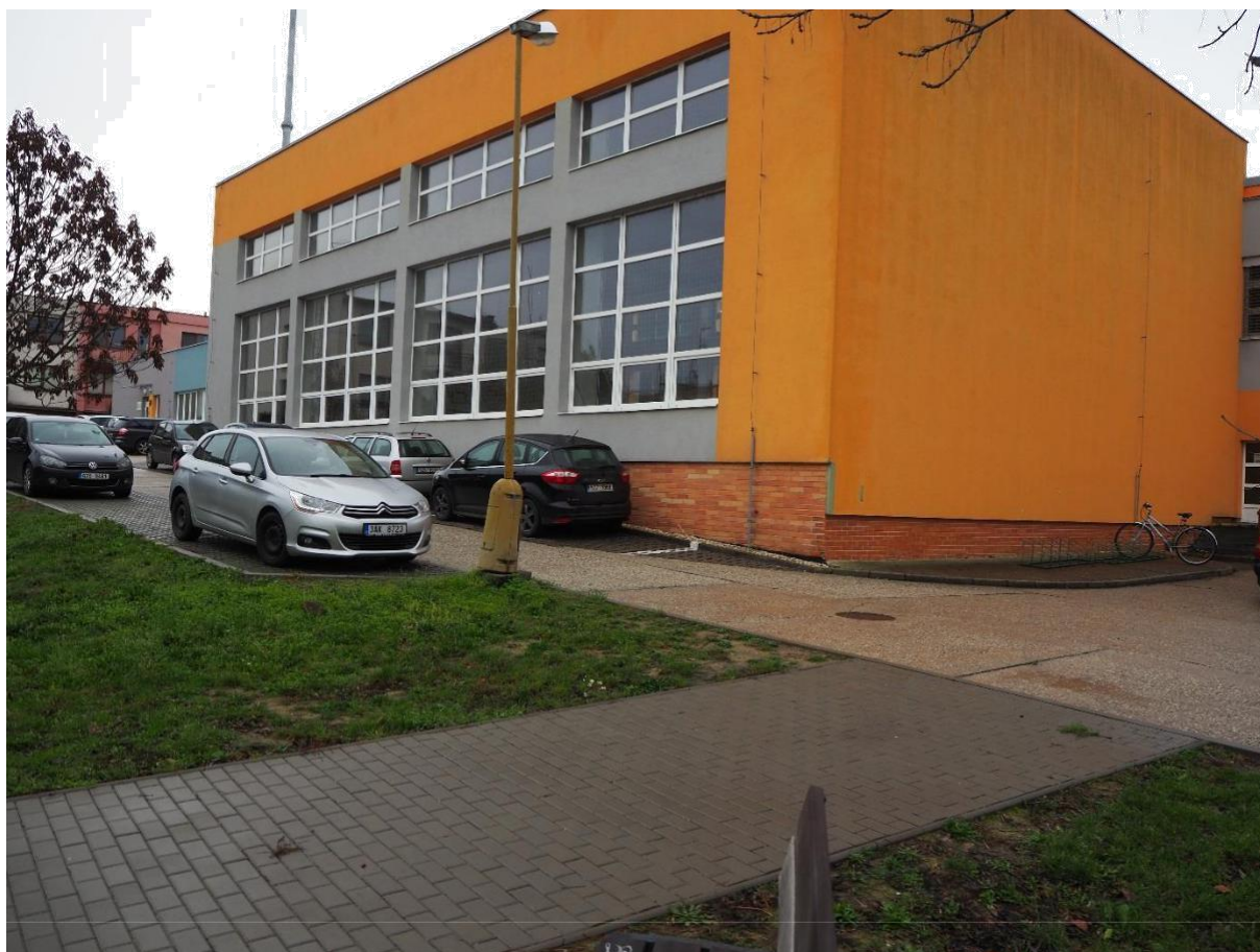
Tělocvična II. stupně ZŠ, Komenského ulice, č. p. 1720
