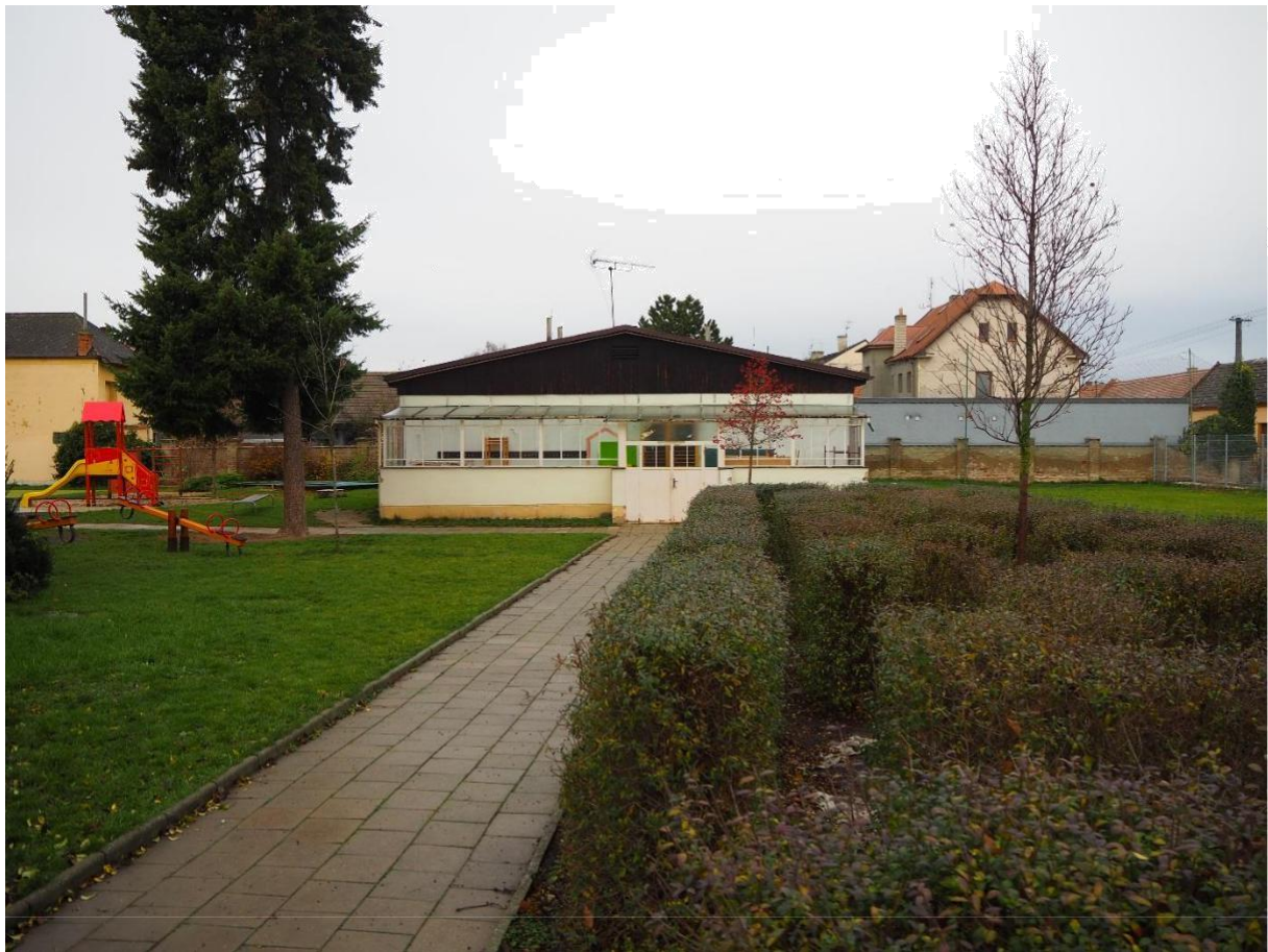
Budova RC Čtyřlístek, areál ZŠ č. p. 715, náměstí Hrdinů
